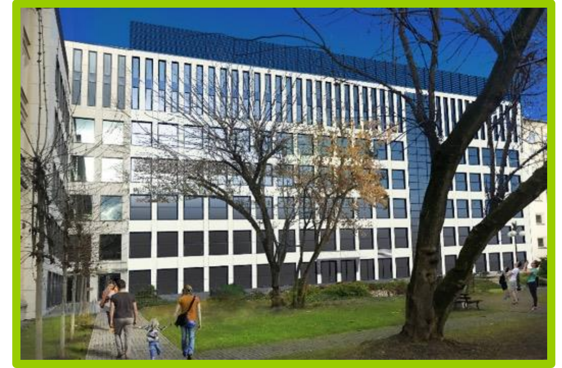
Budowa nowego obiektu dydaktycznego dla WH, WMS, SJO
