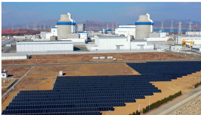
◀ Rys. 1. Współdziałanie odnawialnych źródeł energii ze źródłami bazującymi na wykorzystaniu energii jądrowej stanowi optymalne rozwiązanie z punktu widzenia uzyskania bezemisyjności i stabilnej pracy systemu energetycznego. Na zdjęciu: na pierwszym planie duża instalacja fotowoltaiczna, zaś w tle dwa energetyczne bloki jądrowe typu Westinghouse Electric AP1000 w EJ Haiyang w Chinach (fot. Setao)
