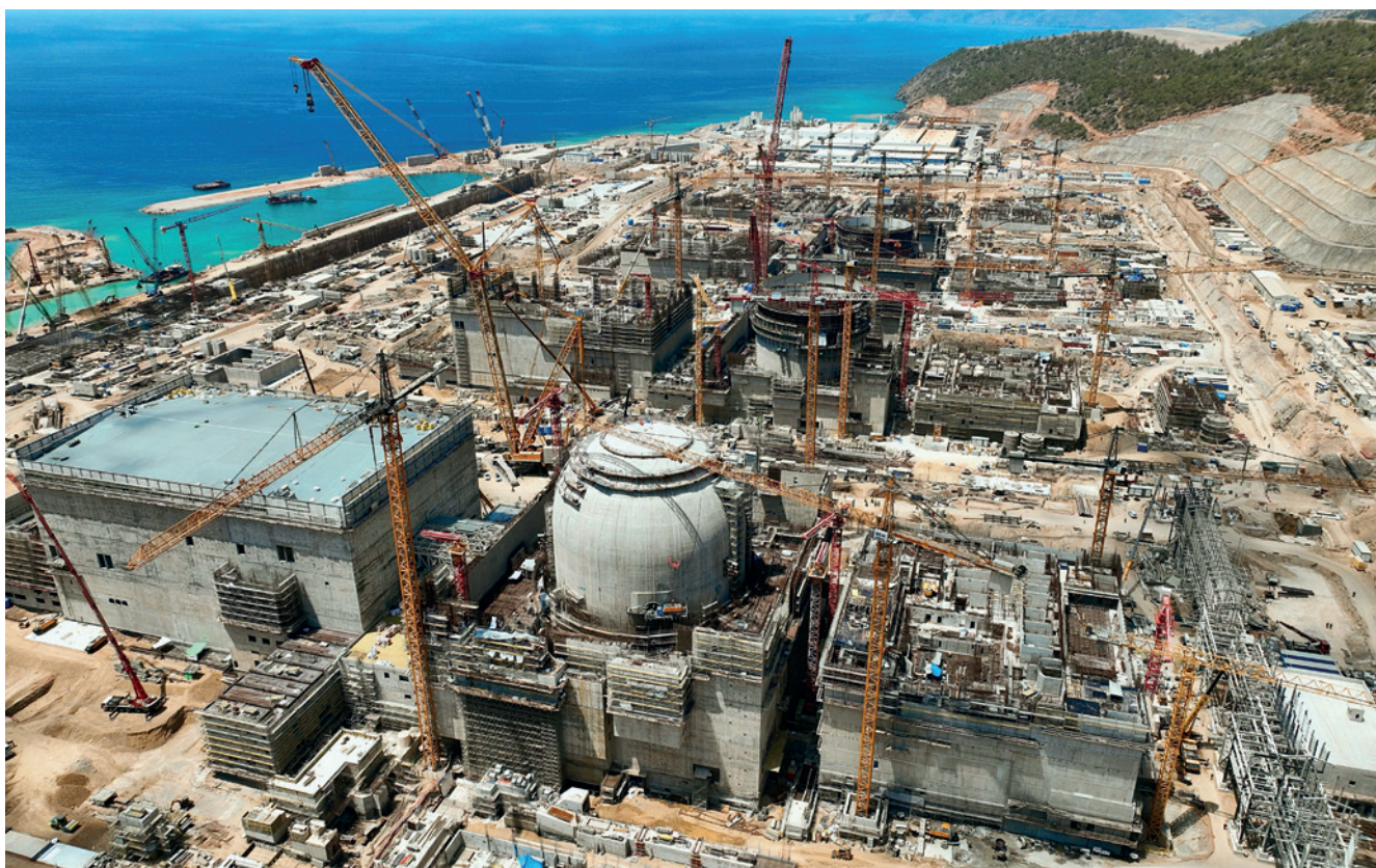
Rys. 10. Pierwszy blok tureckiej elektrowni jądrowej Akkuyu w zaawansowanej fazie budowy. Elektrownia bazuje na rosyjskich reaktorach WWER, ale dostawcą turbozespołów jest francuska wytwórnia koncernu General Electric w Belfort (fot. Akkuyu NPP)
