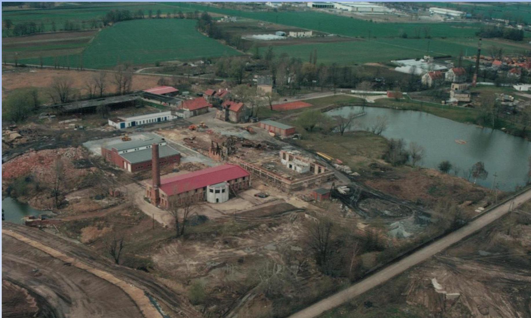
Fot. Ruiny cegielni, ulica M. Przybyły była nieprzejezdna ,początki Alei Dębów
