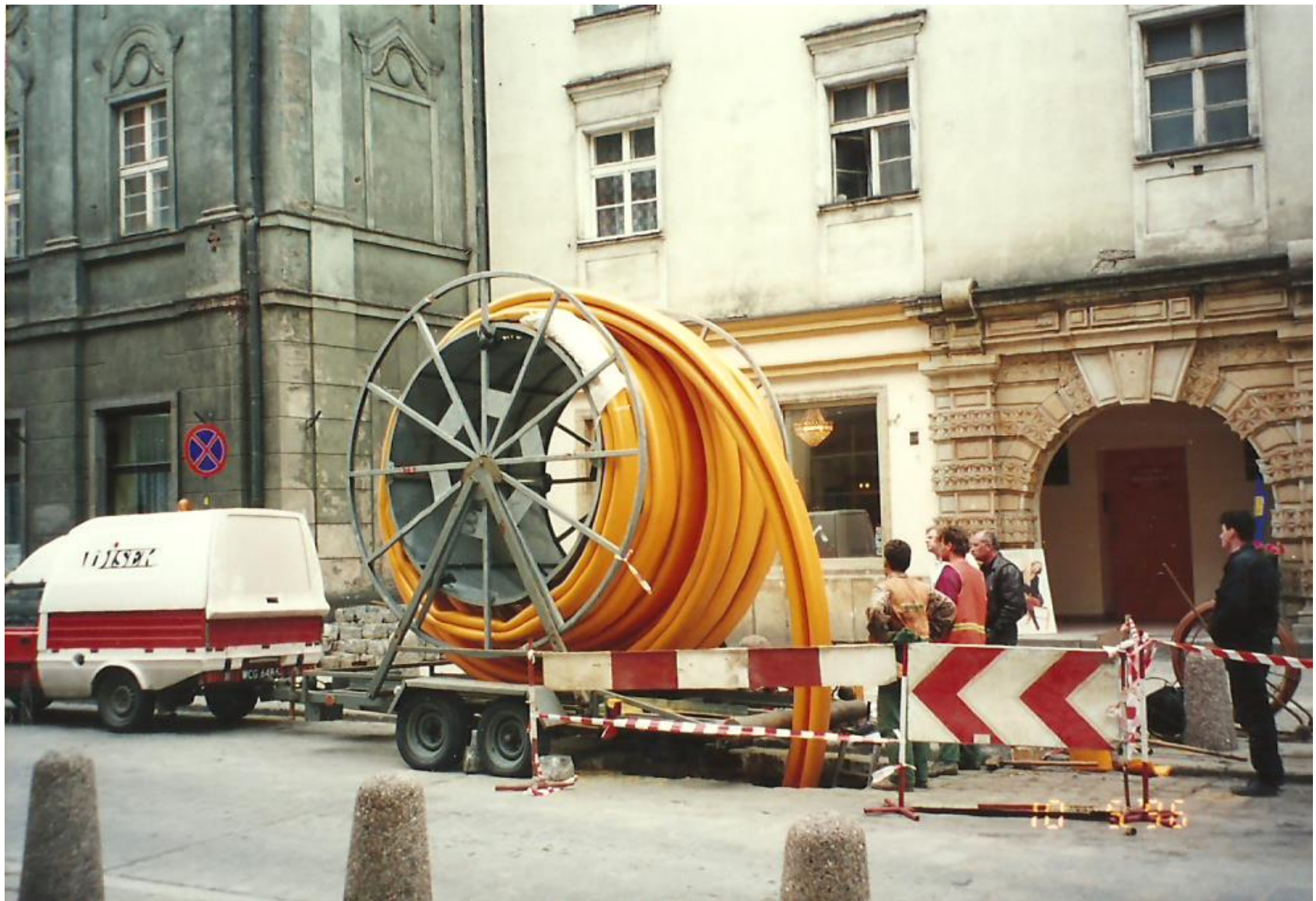
Fot. Technologia U-liner, zastosowanie w Polsce, Wrocław
