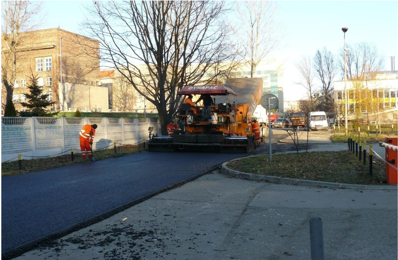
Uniwersytet Wrocławski, droga z asfaltem gumowym, 2008
