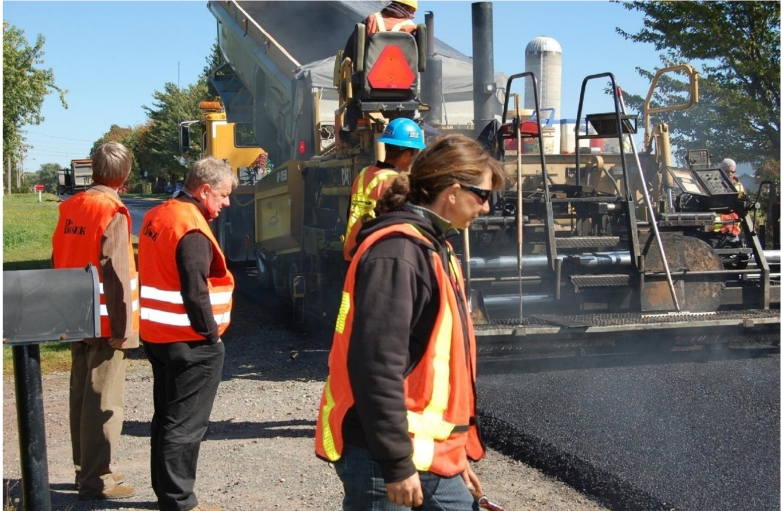
Podczas kładzenia asfaltu gumowego, Victoriaville, Kanada, 2009
