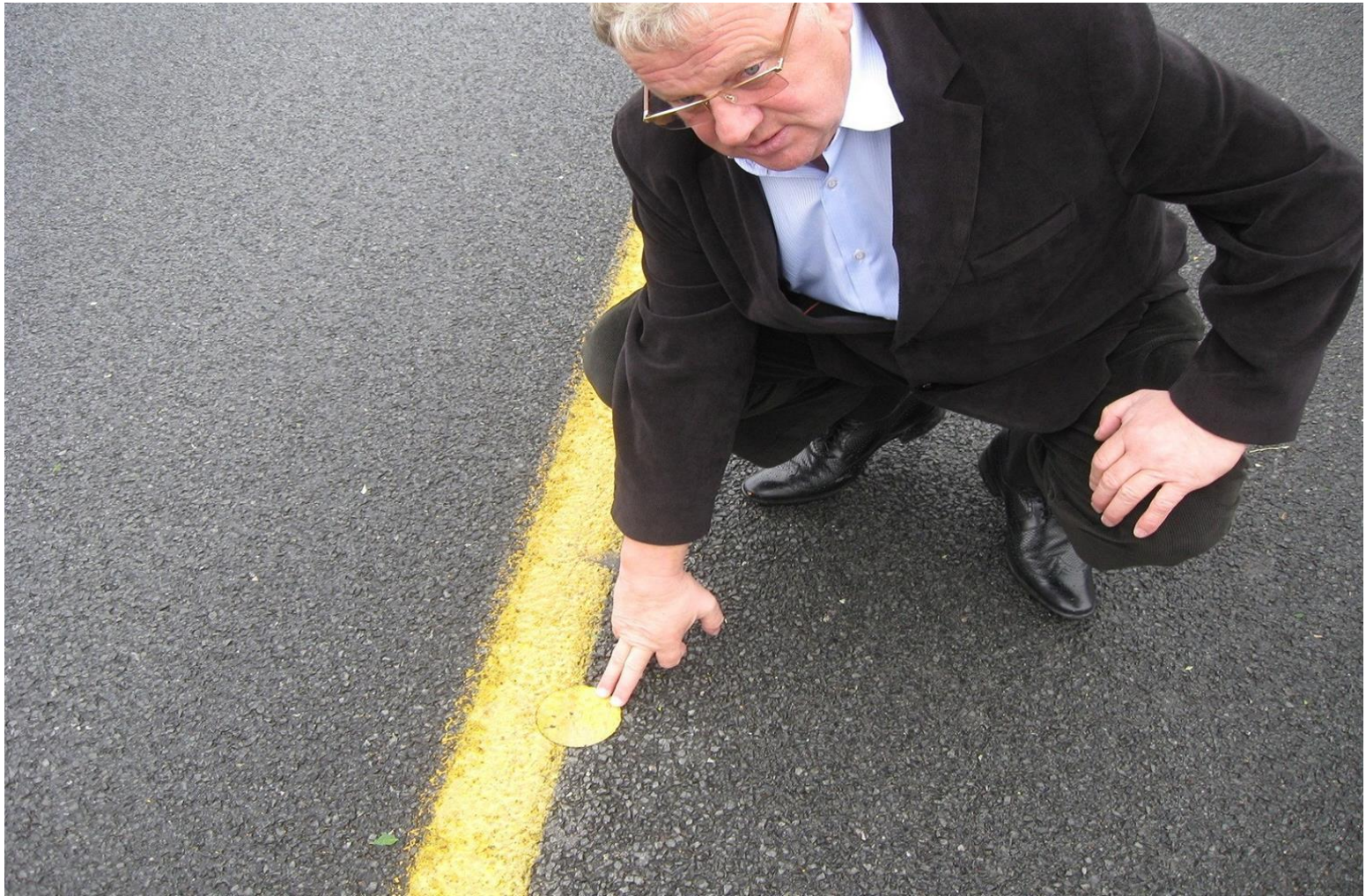
Nawierzchnia drogi wyłożonej asfaltem gumowym, Victoriaville, Kanada, 2009
