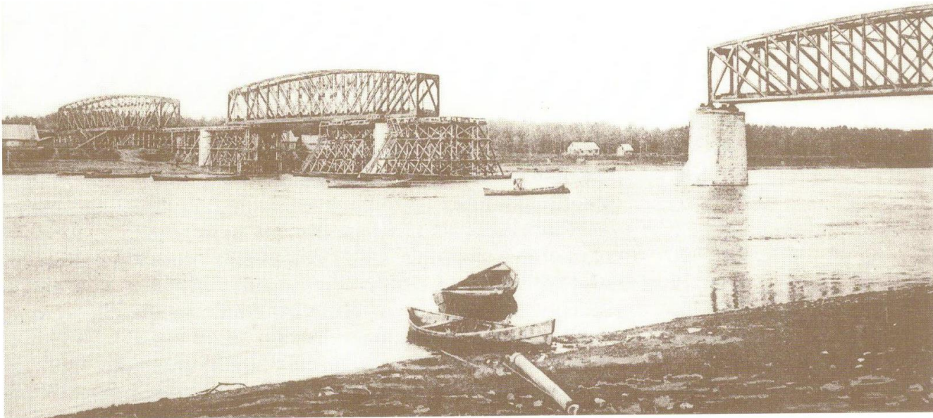
Budowa mostu firmy Rudzki na Dźwinie
