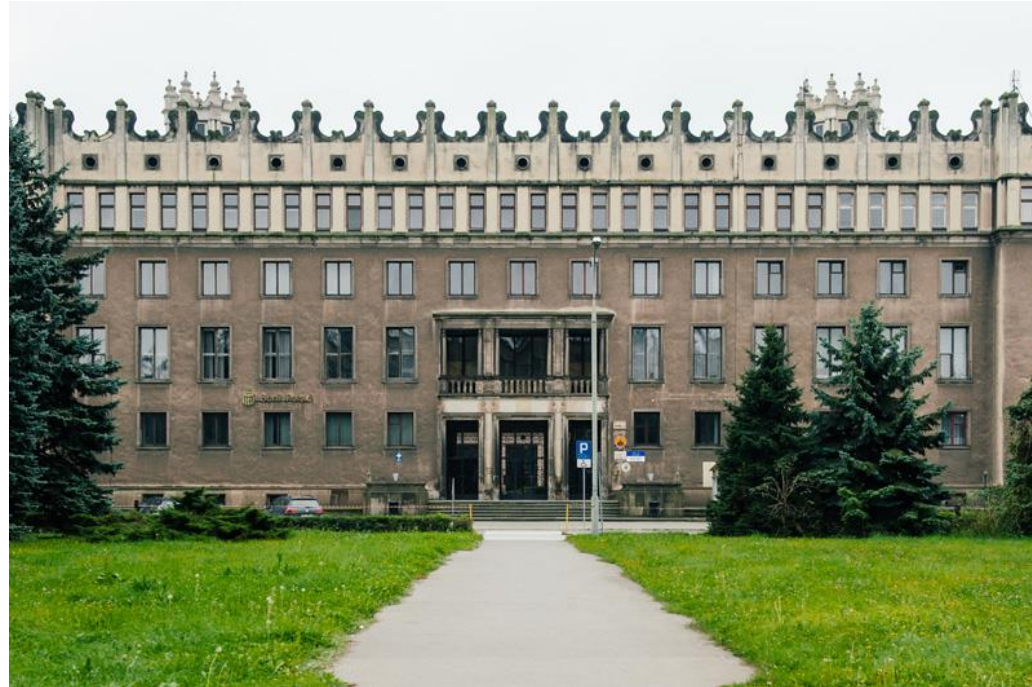
Budynek administracyjny huty
